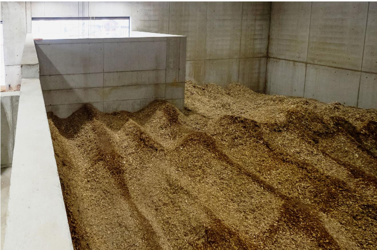
Ein Blick ins 1'965m<sup>3</sup> fassende Holzsilos der Heizzentrale.
