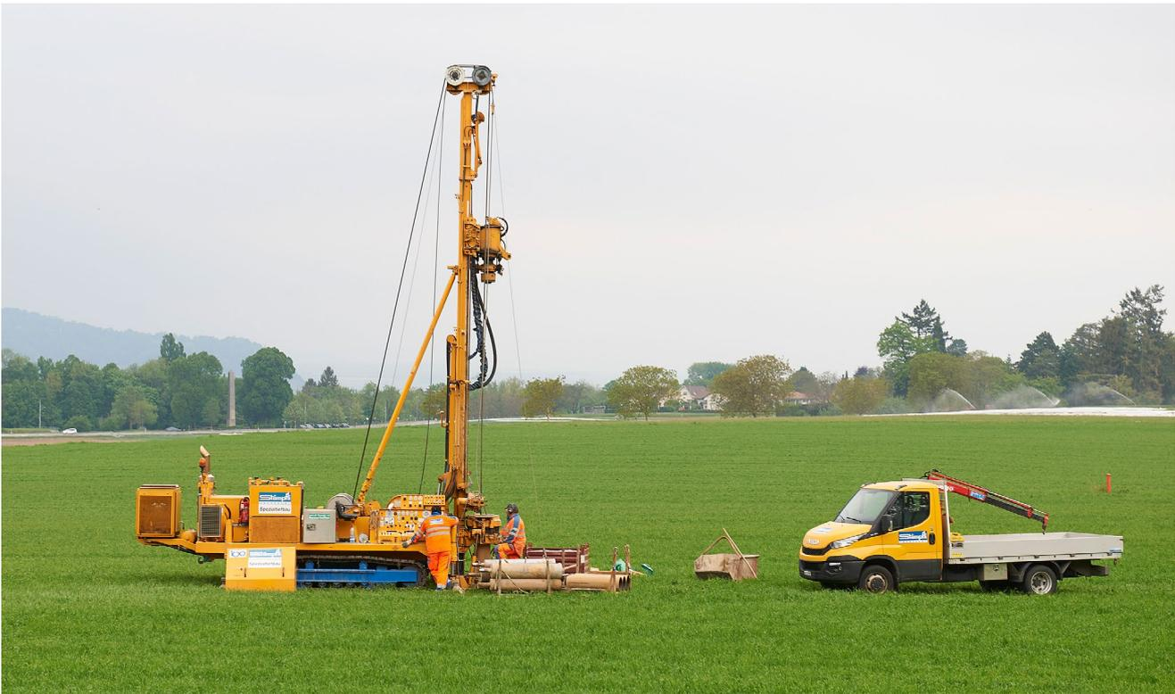
Bohrungen auf der Suche nach einem Ersatzstandort für die Grundwasserfassung.
