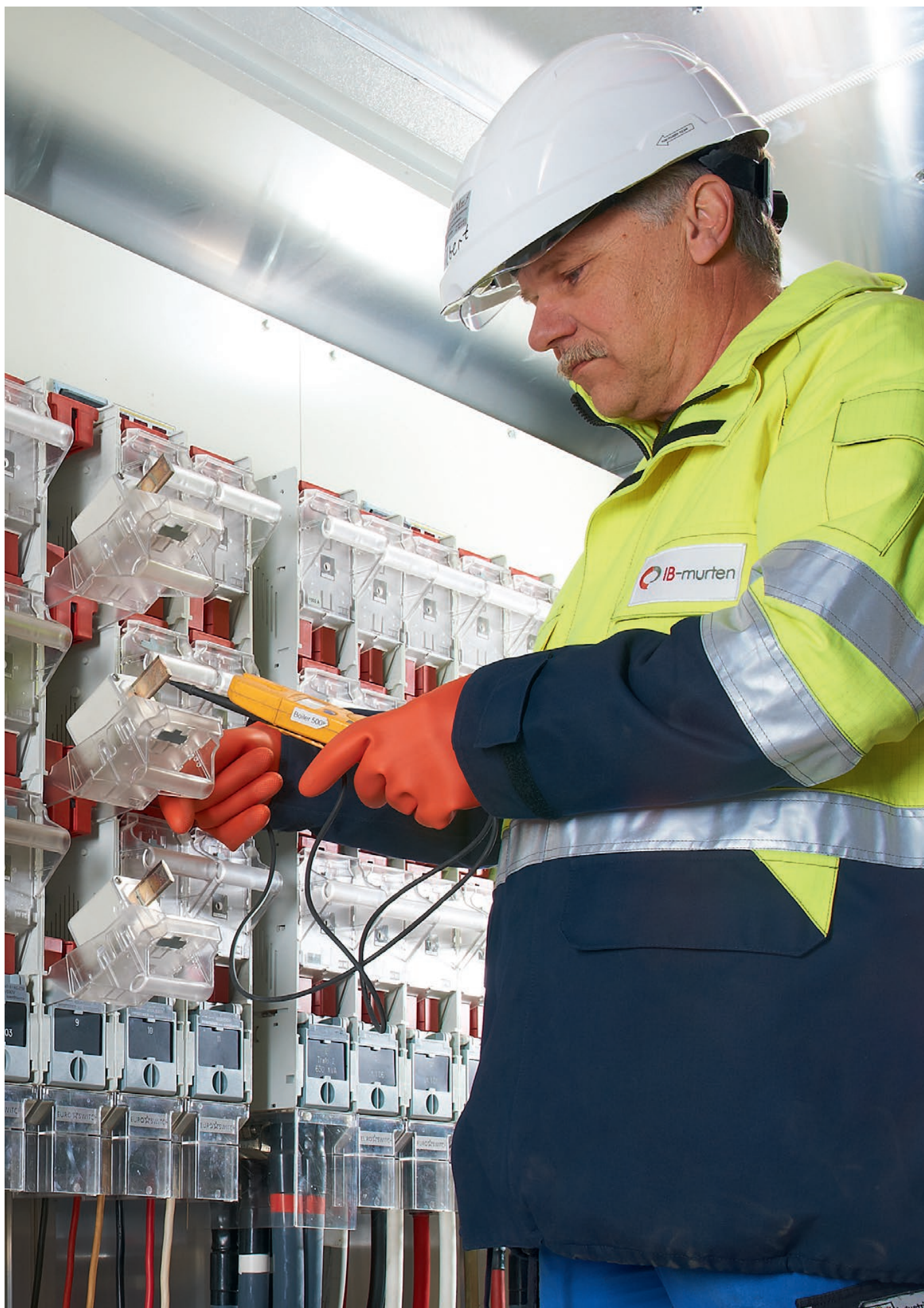
Gilbert Schumacher, Elektroinstallateur, überprüft eine Sicherung der Niederspannungsverteilung der Transformatorenstation Schimmelturm, Murten
