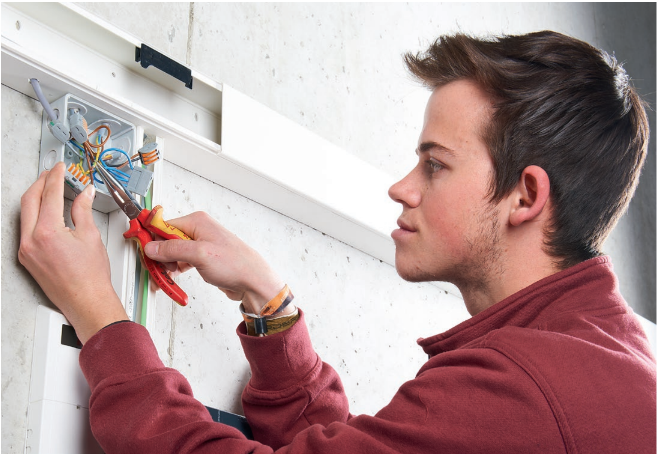
Lernender Colin Schmid (3. Lehrjahr) verdrahtet eine Abzweigdose.
